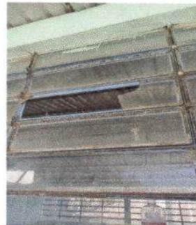
Foto 6: Sustitucion de 26 vidrios en mal estado del modulo 1
